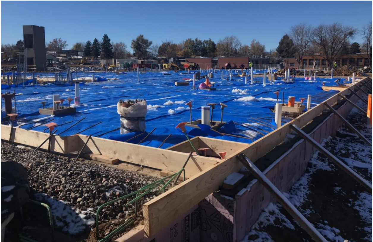
Slab on Grade Prepped and Ready for Pour
